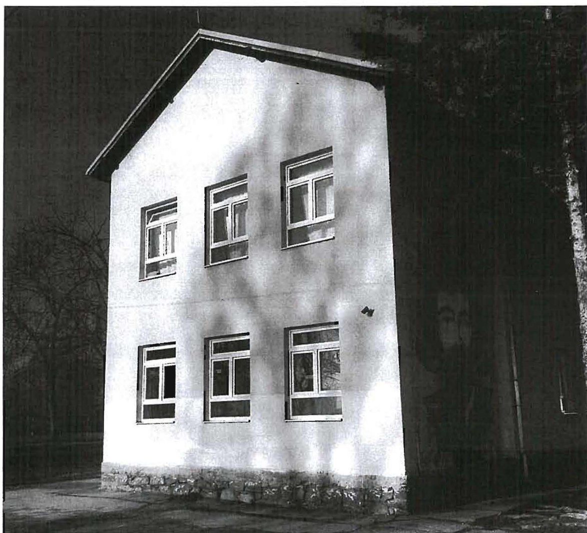
Фотографије фасада објекта бр.1 – школа
