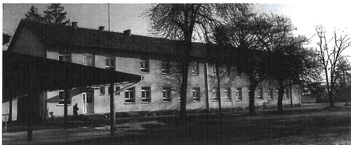
Фотографије фасада објекта бр.1 – школа
