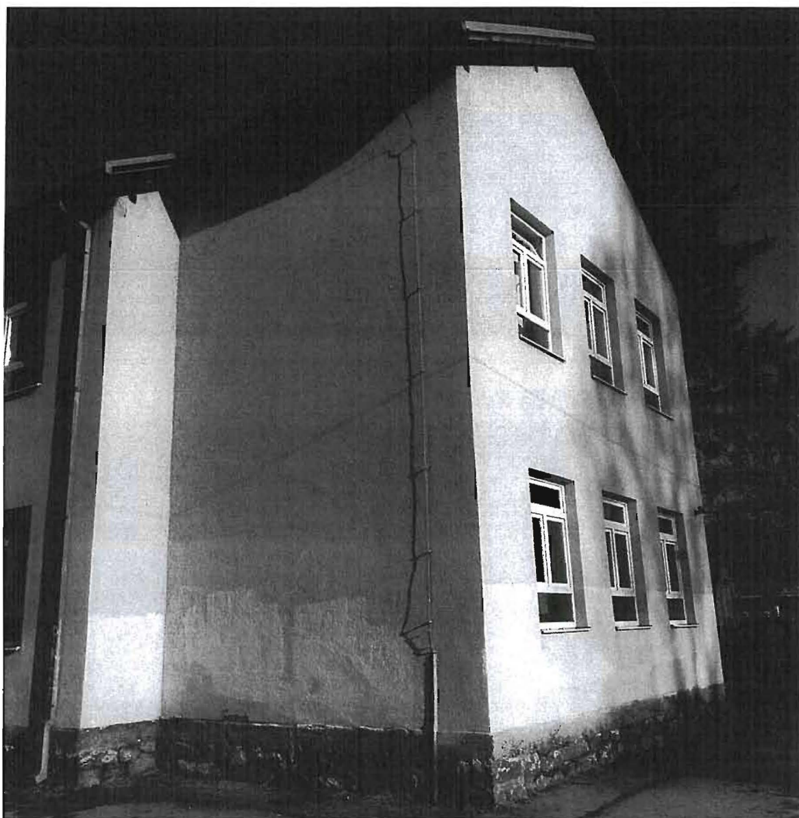
Фотографије фасада објекта бр.1 –школа
