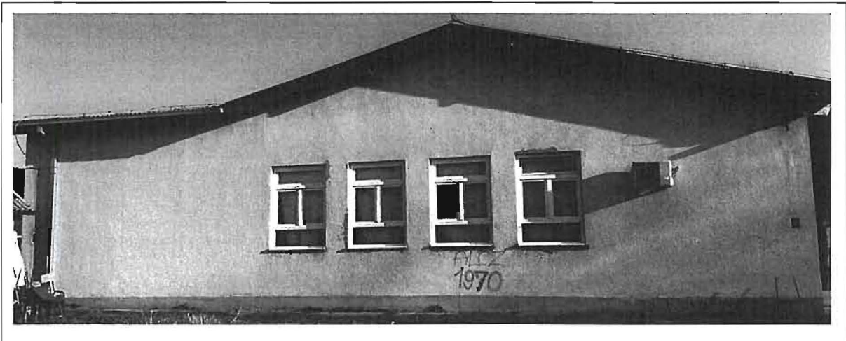
Фотографије фасада објекта бр.2
